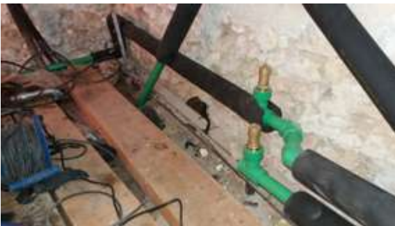
Substitució tubs zona altell
